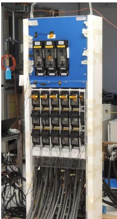
Prova di tipo di un quadro elettrico con fusibile GTr 1000 kVA.
