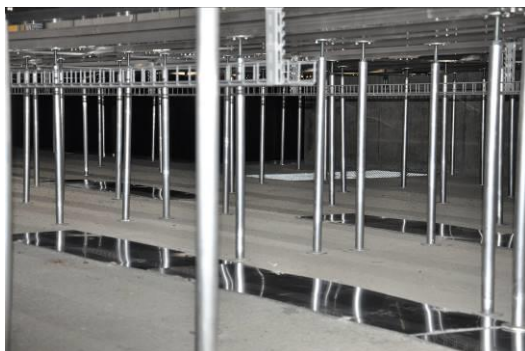
Différentes longueurs de supports sont ainsi préparées et peuvent être utilisées sur le chantier.
